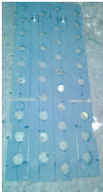
Mithilfe von Öffnungen wurde die Bodenplatte leichter gemacht.
