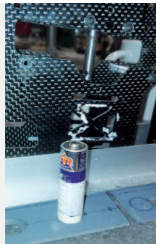
Eine Mignonbatterie half, den richtigen Abstand vom GfK-Rumpf zur Bodenplatte zu ermitteln.
